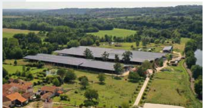
DES GRANDES TOITURES
