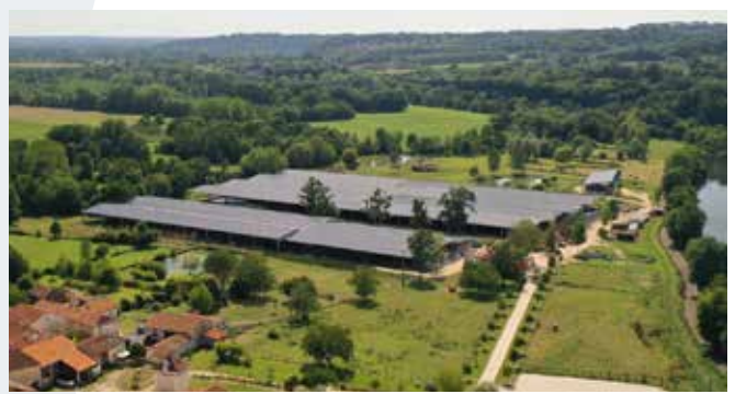
DES GRANDES TOITURES
