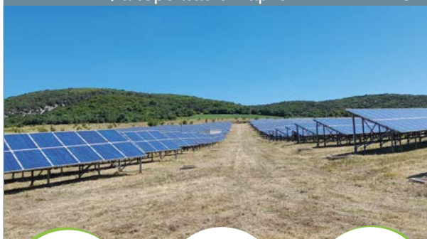
ΕΛΛΑΔΑ - Φωτοβολταϊκό Πάρκο ΗΛΕΚΤΡΙΣΜΟΣ
