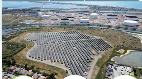
ΓΑΛΛΙΑ - Φωτοβολταϊκό Πάρκο ΦΡΟΝΤΙΝΙΑΝ
