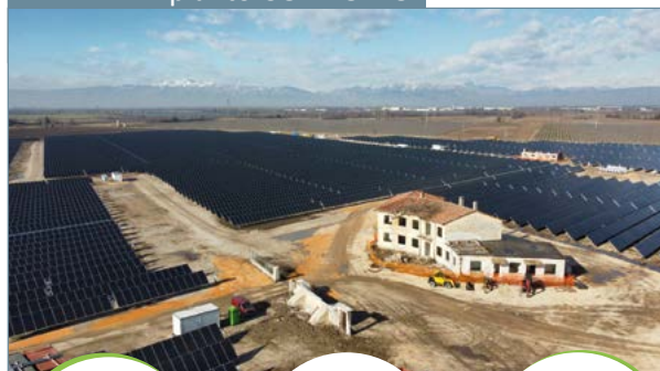
ITALIA - Impianto CODROIPO
